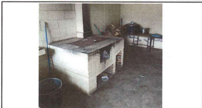
Foto 2: Reparacion de estufa rural
