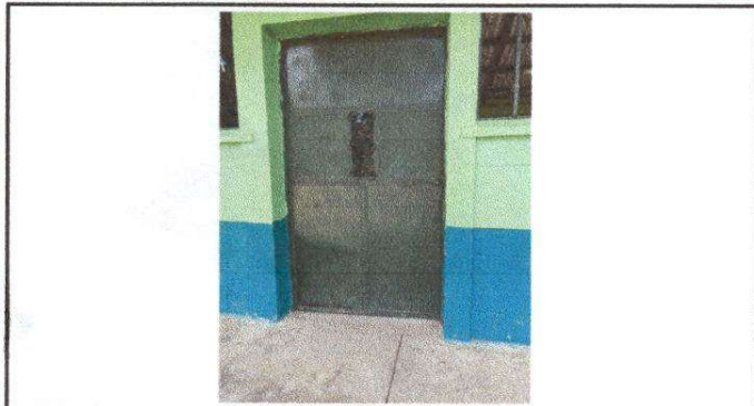
Foto 1: Mantenimiento a las puertas
