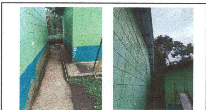
Foto 4: Pintura de muros
